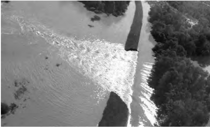
Puknuće nasipa u Rajevu Selu
